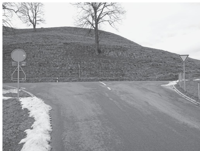
Mit der Strassensanierung wurde der Einlenker in die Kantonsstrasse sicherheitstechnisch verbessert.
