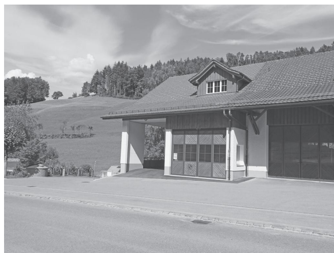
Überdachte und offene Wertstoffsammelstelle mit neuem Einstellraum für die Feuerwehr beim Werkhof.
