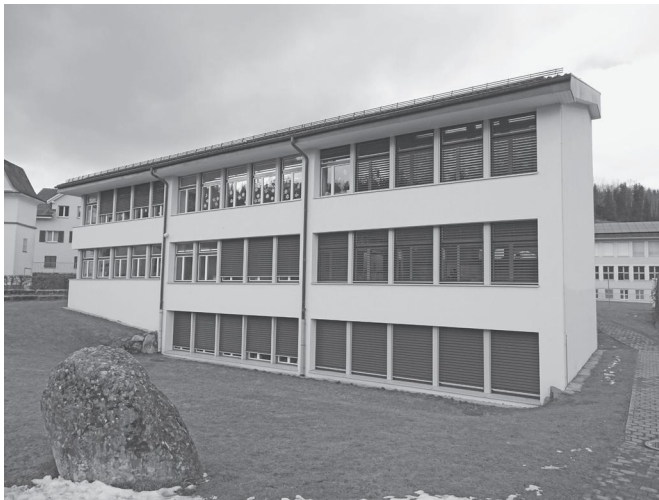
Im Frühjahr 2020 wurde die Fassade des Trakt 2 der Primarschule Mosnang gereinigt.
