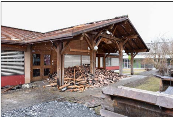
11. Februar: Symbolischer Spatenstich für die grossen Bauvorhaben der Seveler Schule. Bilder Heini Schwendener/W&O
