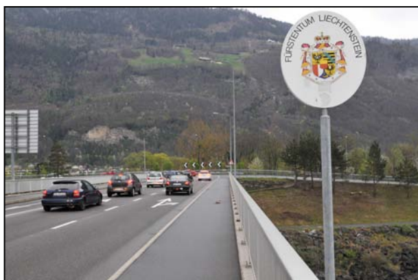
30. März: Die Rheinbrücke Sevelen-Vaduz kann vorläufig nicht zur «Smart Road» werden. Bild Heini Schwendener
