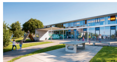
3 Schulhaus/Quartieranlage Gutenswil Nidereggweg 22 | 8605 Gutenswil
